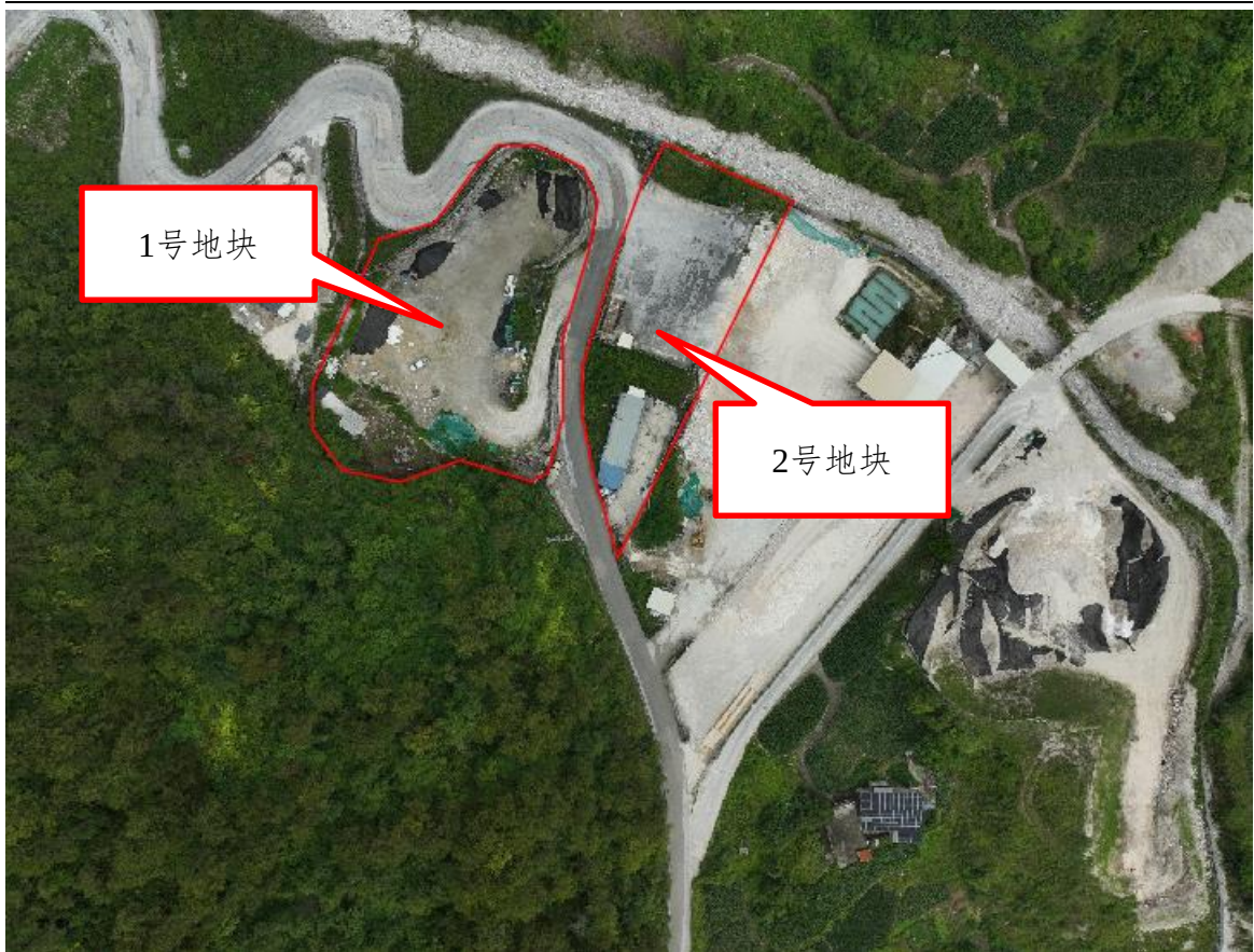
图2.1-2 现状地块航拍照片
